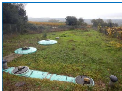
De gauche à droite : fosse à la Boissière Mas Belaure, fosse au Mas d'Agrès et fosse au Mas d'Alhem. ©SATESE 34
