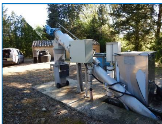
Station d'épuration La Boissière – Bourg, vue de haut et dégrilleur-compacteur. ©SATESE 34
